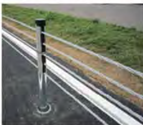
▲反対車線への飛び出し事故を防止するワイヤーロープ式防護柵
