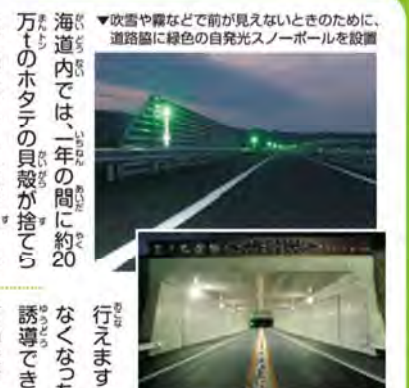
▲道内初となるLED型トンネル照明
